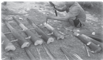
ภาพที่ 6 การตอกลิ้มเพื่อเจาะรูและใช้ไม้ไผ่เสียบทำคานของบ้านและการประกอบ ตัวบ้าน (ถ่ายภาพโดยผู้เขียน เมื่อ 24 เมษายน 2556)
