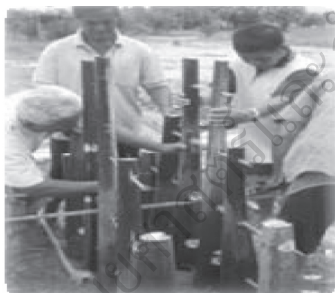
ภาพที่ 7 การตอกลิ้มเพื่อเจาะรูและใช้ไม้ไผ่เสียบทำคานของบ้านและการประกอบ ตัวบ้าน (ถ่ายภาพโดยผู้เขียน เมื่อ 24 เมษายน 2556)
