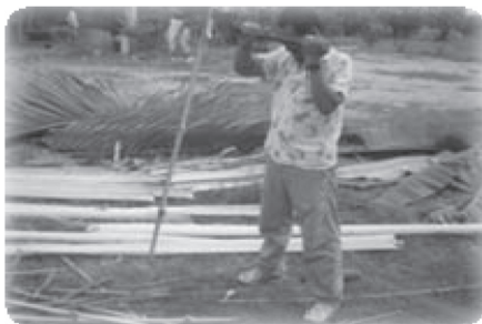
ภาพที่ 5 “ทางจาก” และไม้ไผ่ปลายแหลม เตรียมโครงสร้างของตัวบ้านเทวดา (ถ่ายภาพโดยผู้เขียน เมื่อ 24 เมษายน 2556)
