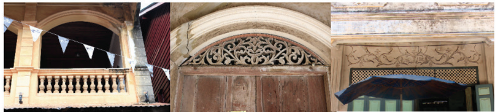
ภาพที่ 3 : การใช้โค้ง (Arch) เสาปูนรูปแบบหัวเสาตอริก (Doric) ไม้แกะสลักวดลายขนมปังขิง ทำเป็นช่องลมลายปูนปั้นบริเวณเหนือประตูทางเข้า (ผู้วิจัย, 2557)
